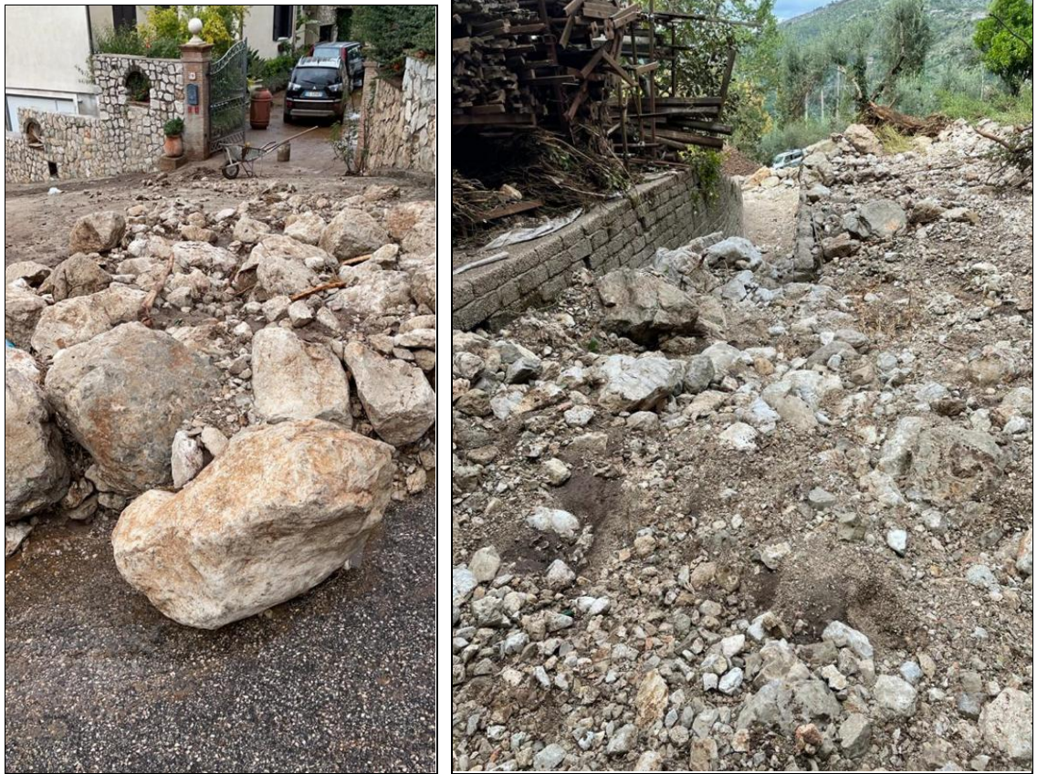
Foto 12, 13 – Colata detritica in località “Giovenco”.
