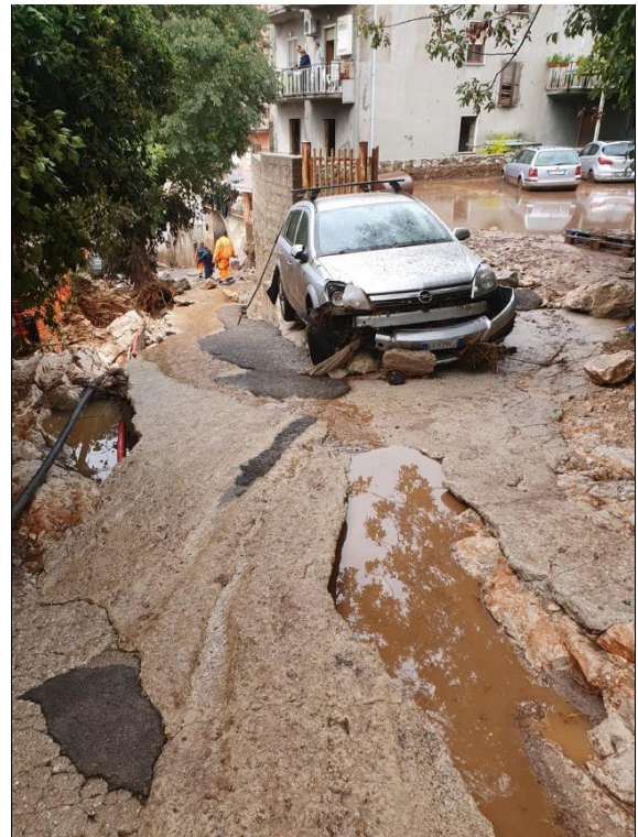
Foto 17, 18 – Colata detritica ed erosione della sede stradale.
