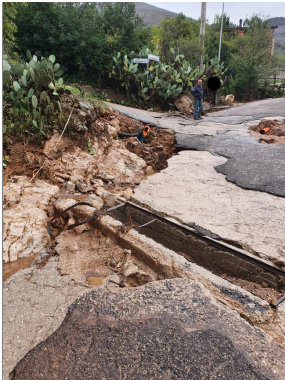
Foto 17, 18 – Colata detritica ed erosione della sede stradale.
