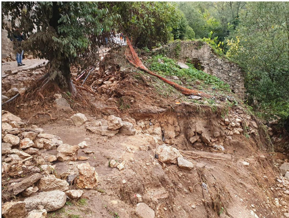
Foto 21 – Erosione lungo le sponde del fossato proveniente da “Valle Colella”.
