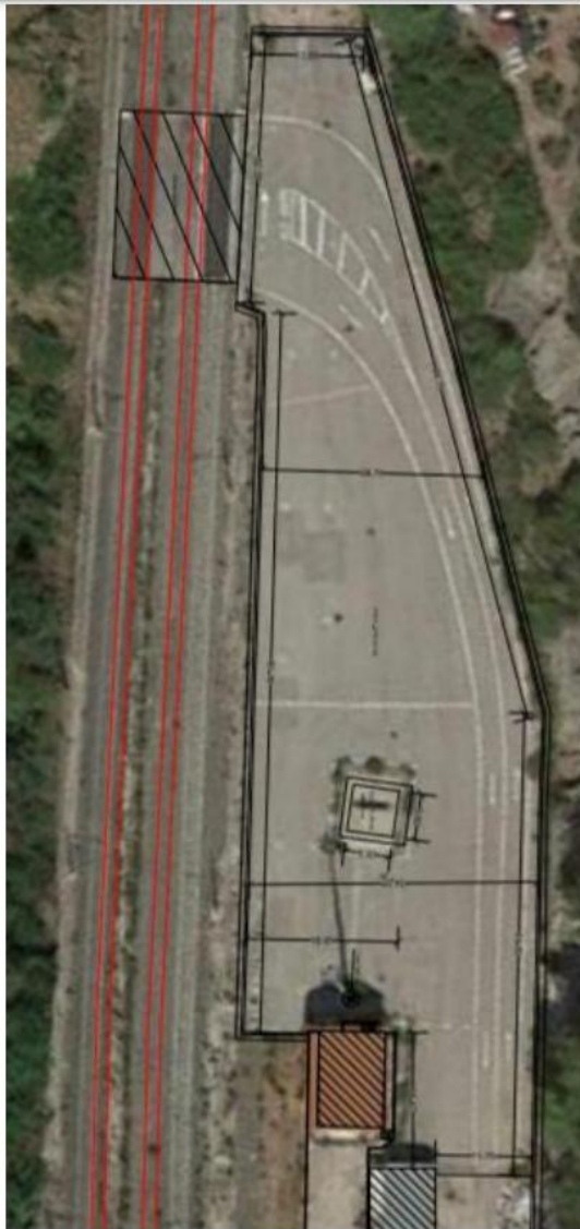
Fig. 13 – Piazzale di Emergenza lato sud (PES Galleria Ferroviaria Vivola - Luglio 2010).
