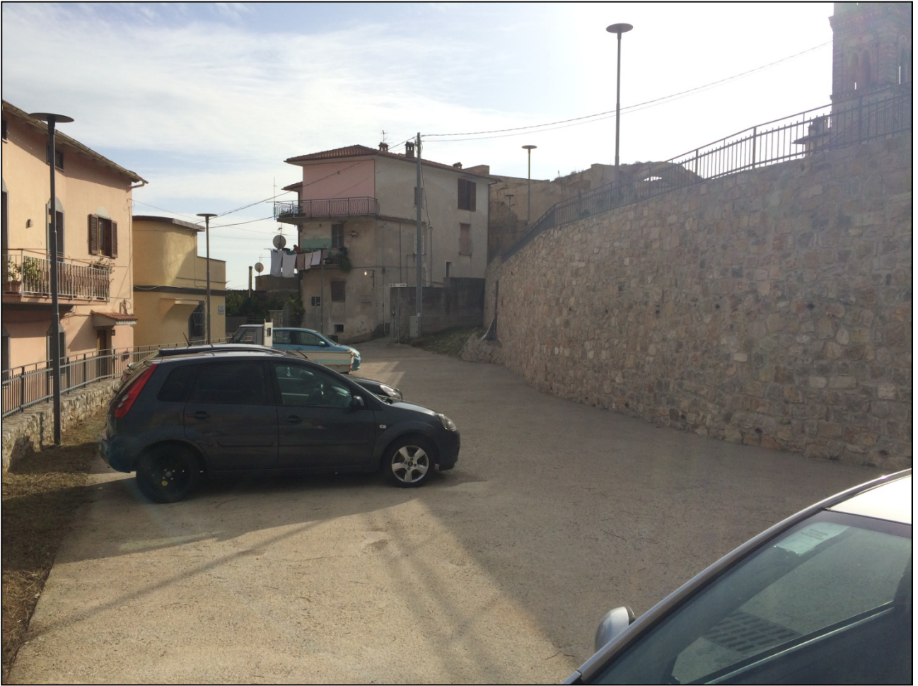
Vista Piazzale Via Santa Maria
